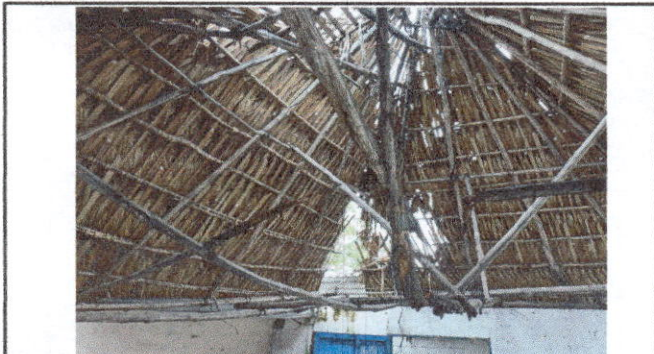
Foto 3: SUSTITUCION DE ESTRUCTURA DE SOPORTE DE MADERA, POR METAL
