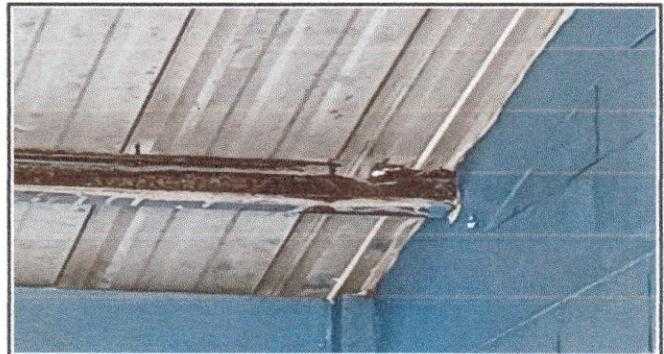
Foto 4: SUSTITUCION DE ESTRUCTURA DE METAL, POR METAL
