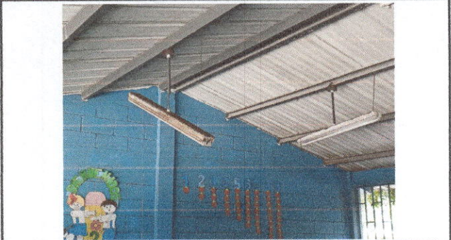
Foto 7: SUSTITUCION DE FOCOS AHORRADORES, Y PLAFONERAS, EN TODOS LOS MODULOS
