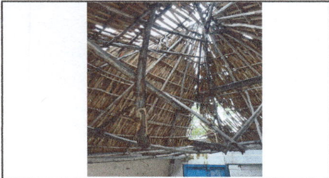
Foto 1: SUSTITUCIÓN DE TECHO DE PALMA, POR LAMINA TROQUELADA ALUZINC CALIBRE 26
