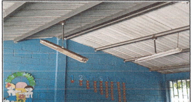
Foto 2: SUSTITUCION DE LAMINA, POR LAMINA TROQUELADA ALUZINC CALIBRE 26
